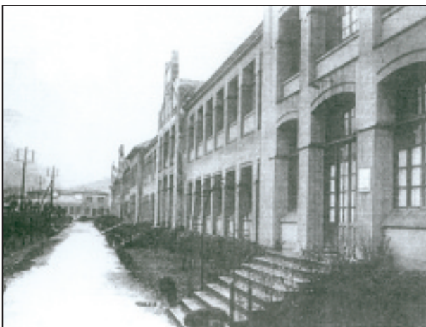
Fachada del Sanatorio Adaro después de las ampliaciones.
