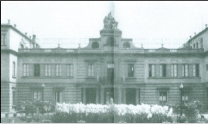
Fachada principal del Hospital de San Juan de Dios de la Avenida Diagonal.
